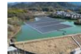
郷之池水上太陽光発電所
